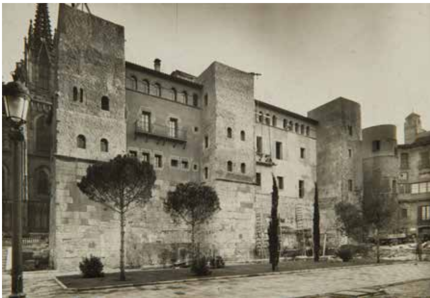
Fig. 2. Remodelació de la façana de l'avinguda de Catedral de la Casa de l'Ardiaca, 1958. AFB_Urb_3098. Autor desconegut.
